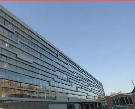
Máriássy Office Building
